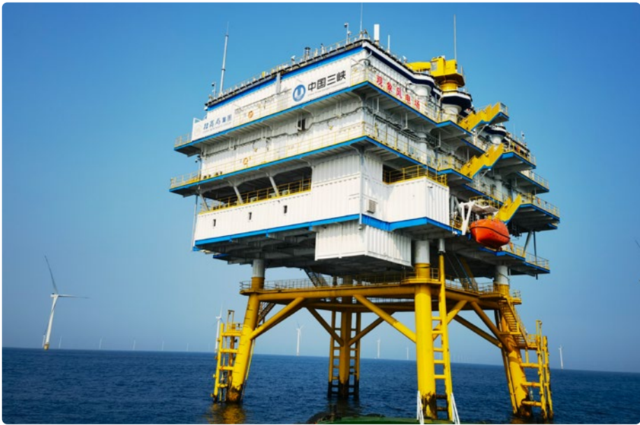
海上风电场升压站
